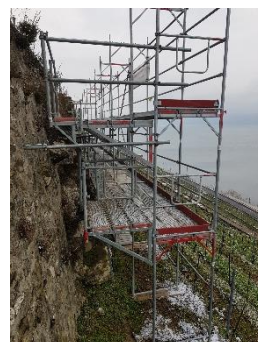
Travaux sur le mur Dézaley
