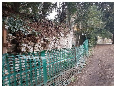
Travaux sur le mur Hermitage
