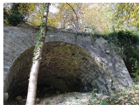
Travaux sur ancien funiculaire Sauvabelin
